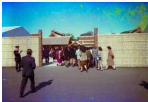
写真14 大嘗宮の入口①
