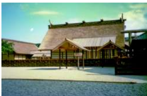
写真16 大嘗宮の主基殿
